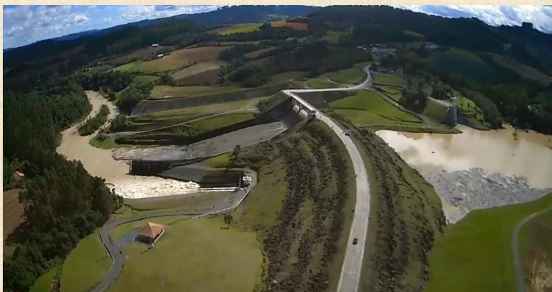
Barragem sul Ituporanga
